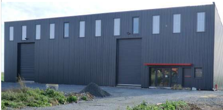
Atelier de services en cours de construction (le 15 octobre 2022)
