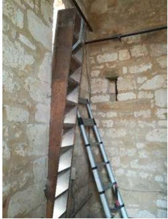
Dans le clocher, les abat-sous grillagés à neuf par l'intérieur sont maintenant reposés dans leurs ouvertures. Après démontage et restauration, les deux cadrans d'horloge ont été réinstallés à leurs emplacements d'origine.
